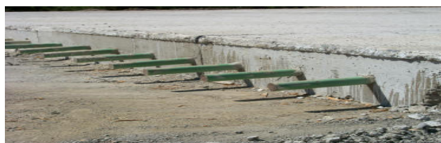
Стальная арматура передачи нагрузки
