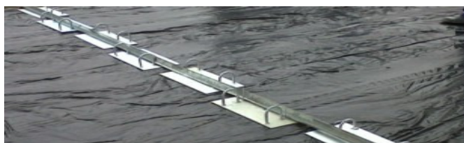
Стальные пластины передачи нагрузки
