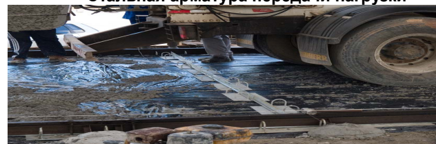
Полиэтиленовая пленка, соединительные индукторы, стальные пластины передачи нагрузки
