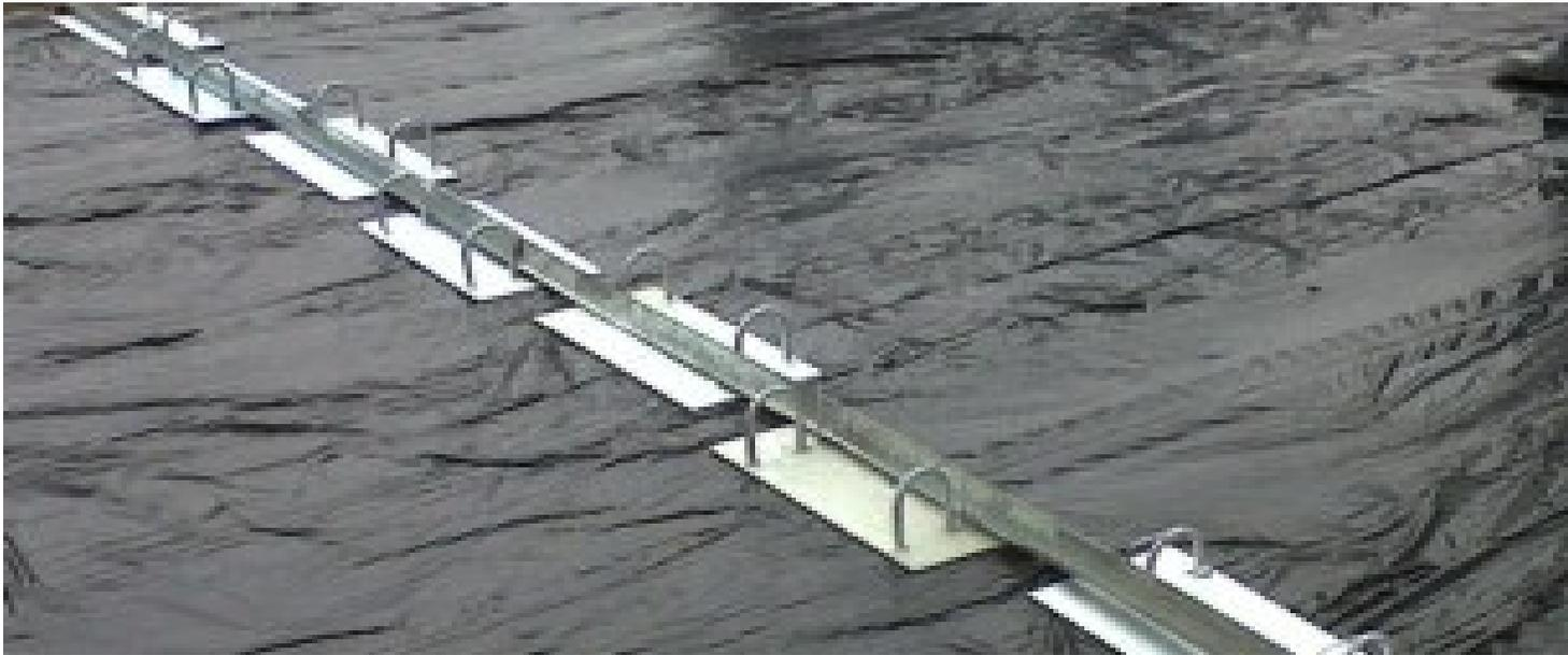
**Antes de espalhar o betão (concreto) as placas de aço de transmissão de carga têm de ser colocadas sobre um filme plástico sob cada um dos lados da futura junta.**
