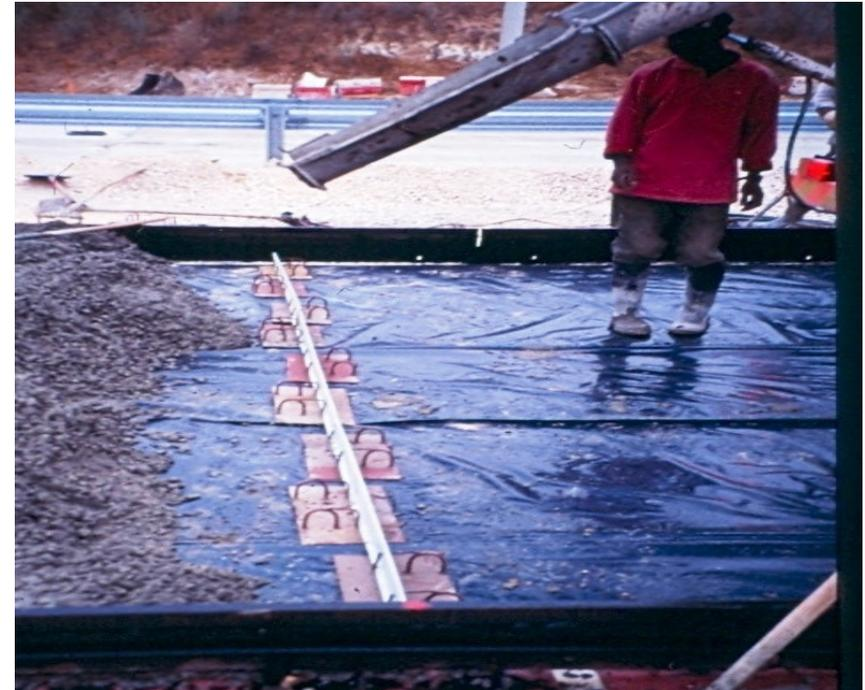
**Um Indutor de Junta estanque é colocado sobre as Placas de Aço de Transmissão de Carga para assegurar a abertura automática da junta naquela exacta posição.**
