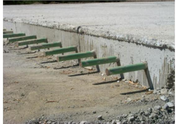
As técnicas de construção usadas durante décadas para garantir a continuidade das lajes, com juntas macho-fêmea, varões de transmissão de cargas ou mesmo armaduras contínuas, nunca conseguiram impedir a fracturação das lajes devidas às tensões de retracção, a assentamentos diferenciais e/ou a empolamentos do terreno natural.
